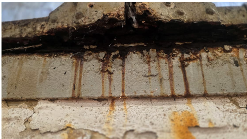
Defekte Fenster + Fensterrahmen
