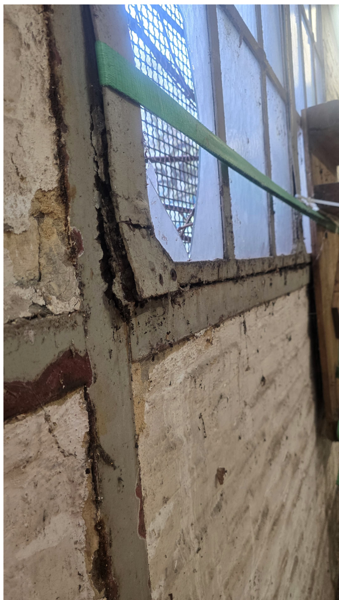
Defekte Fenster + Fensterrahmen
